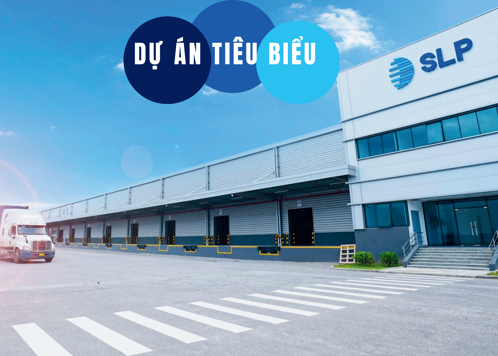
NHÀ MÁY SLP LONG HẬU - KCN LONG HẬU, XÃ LONG HẬU, H. CẦN GIUỘC, T. LONG AN
